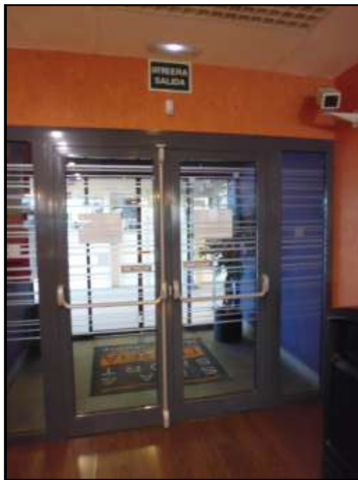
Fotos 6 y 7: señalización de salidas en puertas y salida de pista de hielo y escaleras de emergencia
