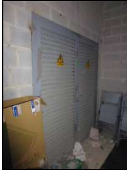
Foto 9: ubicación del centro de transformación con acceso restringido y señalizado. Desorden en pasillos
