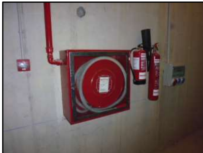
Foto 5: pulsador de emergencia, extintores ABC y CO 2 y BIEs en pasillo frente a sala de calderas
