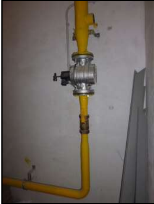
Fotos 1 y 2: electroválvula de seguridad suministro de gas y llave de cierre y central de control
