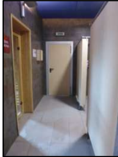
Foto 8: puerta de salida junto a sauna cerrada y sin señalizar correctamente como “salida de emergencia”
